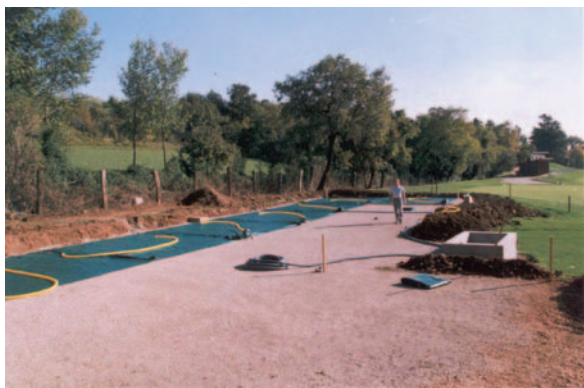
Posa dei tubi di drenaggio nel green
