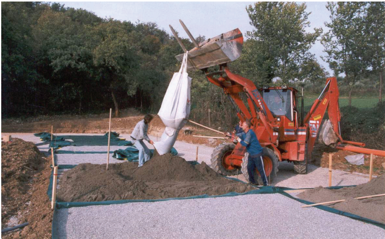
Allestimento dei topsoil nel green
