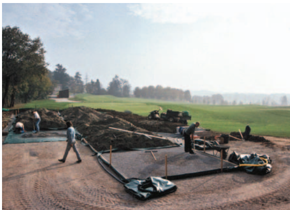
Lavori di preparazione del green
