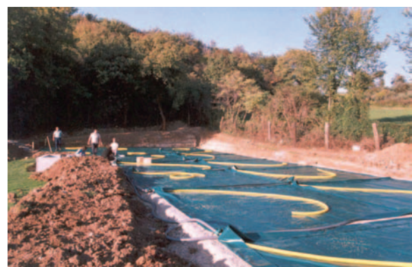
Tubi di drenaggio collocati nel green
