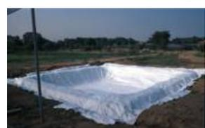
Fig. 06 – Impermeabilizzazione del laghetto di recupero acque
