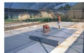
Fig. 05 - Operazioni di impermeabilizzazione dell'area di riciclo
