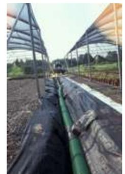
Fig. 03 – Sistemazione del drenaggio sotto i corridoi di servizio
