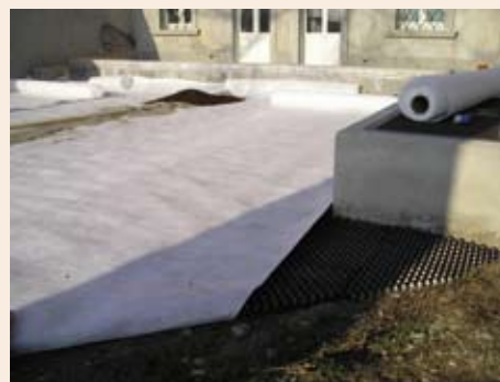
La posa dello stato drenante in pannelli preformati al di sopra del quale viene steso un telo filtrante
