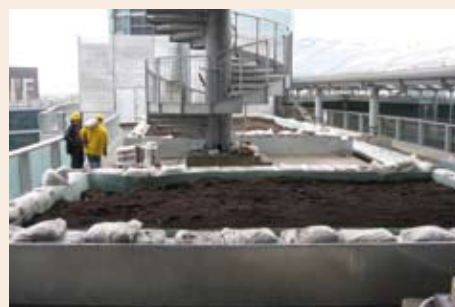
La realizzazione delle vasche per il verde intensivo lungo il percorso presidenziale
