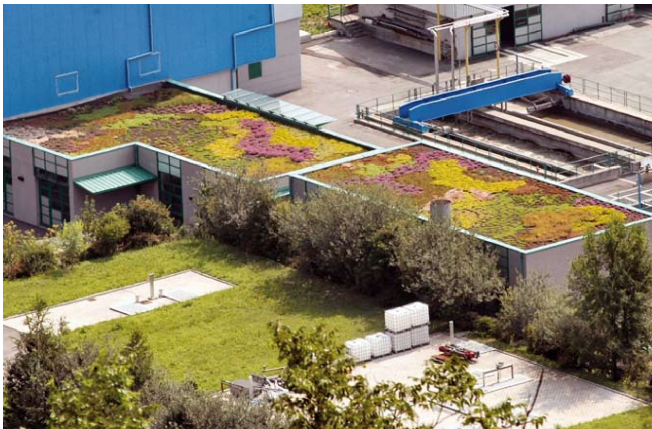
Coperture a verde estensivo sugli impianti del depuratore acque di Bolzano - Foto Helga Salchegger
