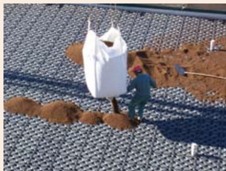
Riempimento dei serbatoi dell'elemento drenante con substrato drenante alleggerito
