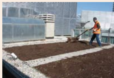
Dopo lo spaglio i Sedum vengono coperti da un sottile strato di substrato successivamente rullato
