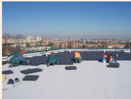
La posa dell'elemento Drenante
