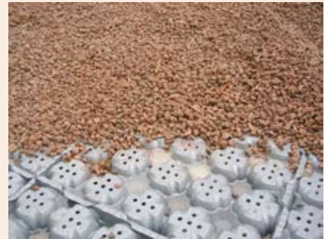
Strato drenante tipo Geodrein spessore 6 cm circa su tutta la superficie dell'aiuola e successivo riempimento degli interstizi con lapillo vulcanico
