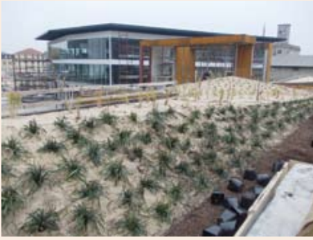
La messa a dimora delle piante graminacee su telo pacciamante biodegradabile.
