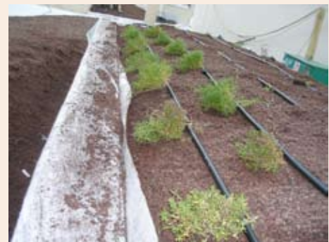
Impianto di irrigazione ad ala gocciolante, messa a dimora della vegetazione e pacciamatura con lapillo vulcanico, per ottenere un raccordo più naturale tra i cordoli e le aiuole sui bordi sono stati posizionati ciottoli di marmo
