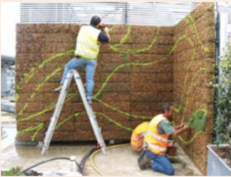
La realizzazione del verde verticale
