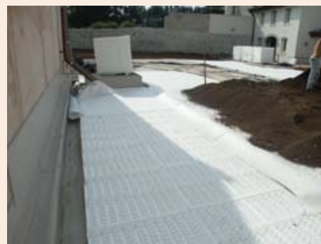
La posa degli elementi componenti la stratigrafia nella zona a verde pensile
