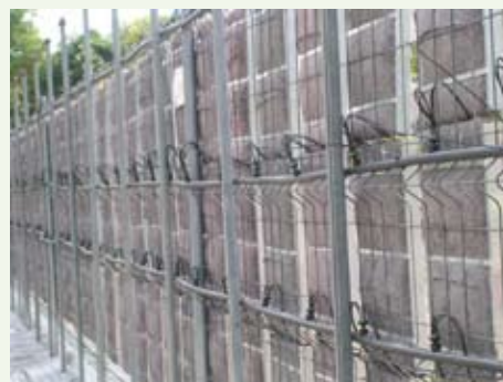
Greens 3 – Particolare dell'impianto di irrigazione automatico a goccia
