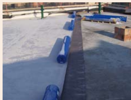
La posa dello strato di impermeabilizzazione e del feltro di protezione meccanica al di sopra
