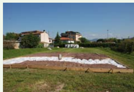
Fasi di impianto del tetto verde simulato a terra nel sito sperimentale di Pisa: da notarsi lo strato sottostante di cuscini di perlite ricoperto da AgriTERRAM® (come da sistema PERLIGARDEN®), entrambi gentilmente forniti da Perlite Italiana.
