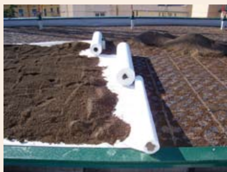
Stesura del substrato di coltivazione sopra il telo filtrante
