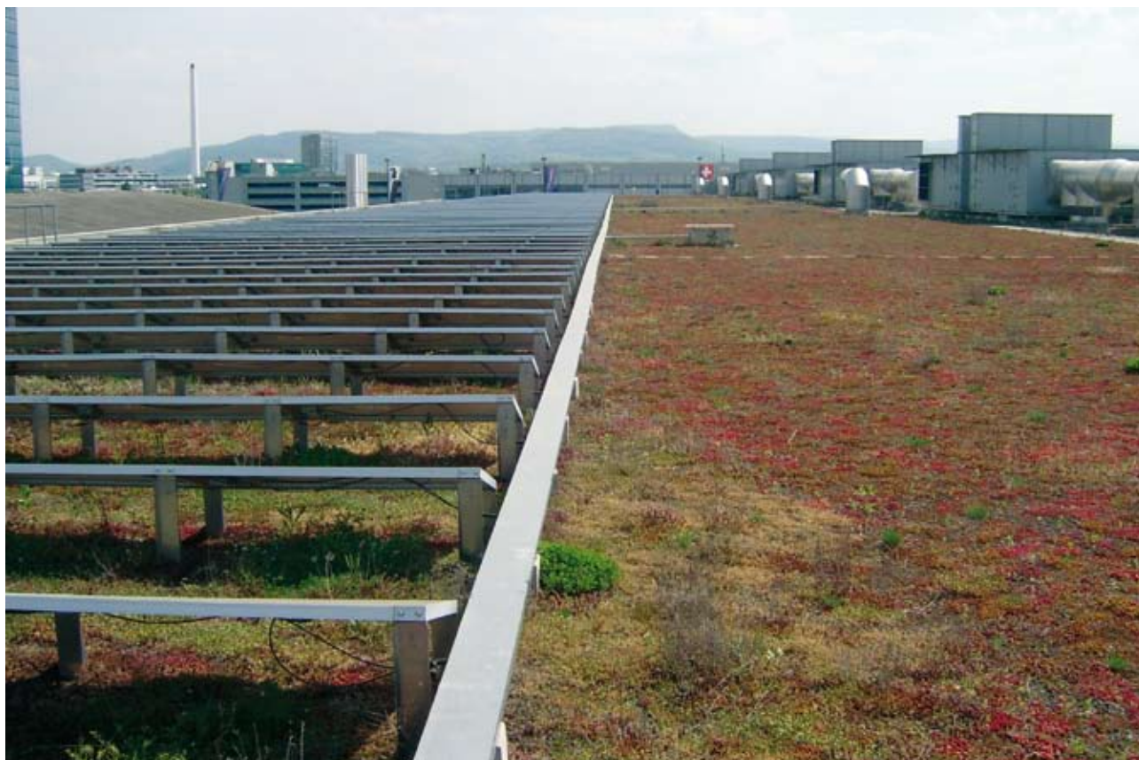
Copertura della fiera di Basilea. Integrazione tra pannelli fotovoltaici e verde pensile estensivo – Foto Paolo Abram
