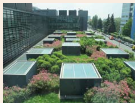
Il verde in copertura a regime
