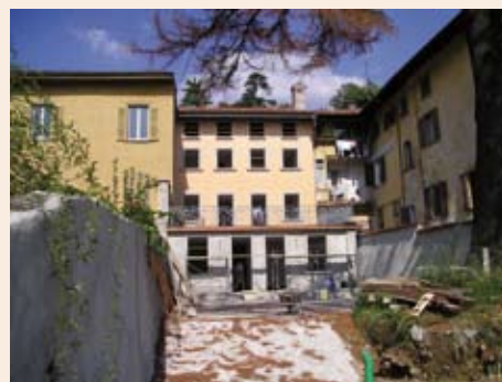
L'area di intervento all'avvio dei lavori
