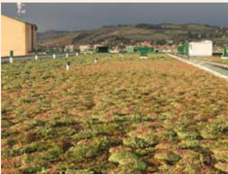
La copertura dopo 18 mesi dal termine dei lavori
