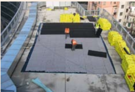
La realizzazione della stratigrafia telo di impermeabilizzazione, feltro di protezione meccanica, elemento drenate in pannelli preformati
