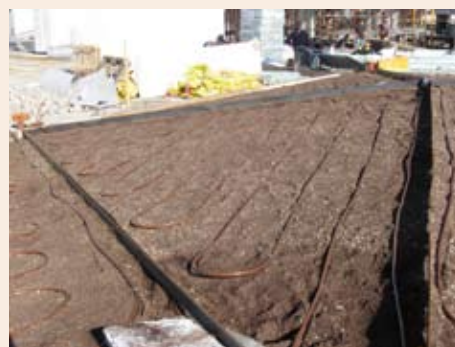
Pev.jpg: stesura dell'impianto di sub irrigazione con ala gocciolante. Le canalizzazioni rimangono al di sotto dello strato più superficiale del substrato.
