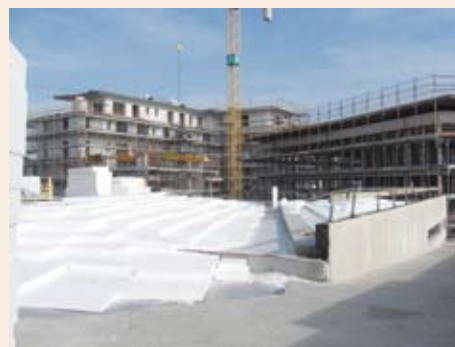
La posa dei pannelli di polistirene, stratificati a realizzare pendenze e rilevati
