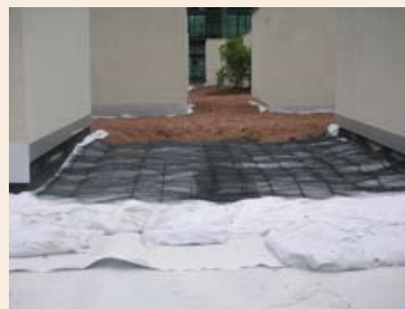
La preparazione della stratigrafia per il verde pensile intensivo
