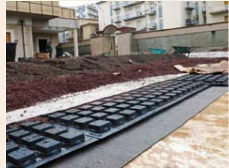
Le fasi di realizzazione della copertura a verde
