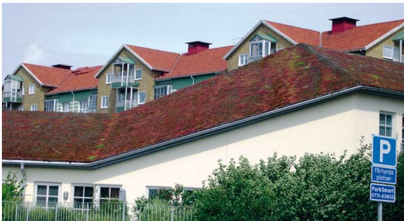
Copertura a verde estensiva di una casa di Malmö – Svezia. Foto Paolo Abram
