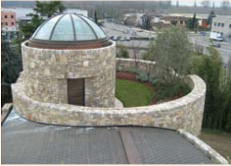
Il complesso a lavori terminati
